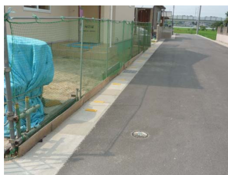
土留めをして周辺に配慮
