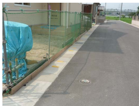
土留めをして周辺に配慮
